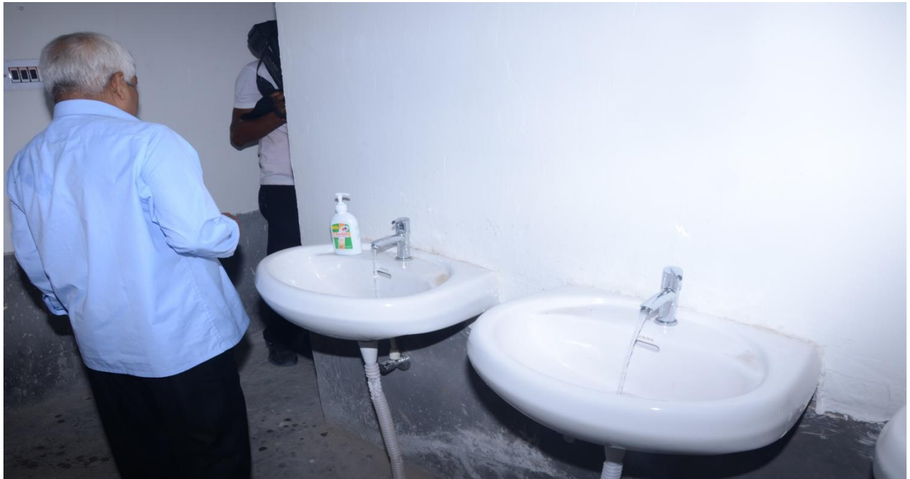
Girls Toilet Room
